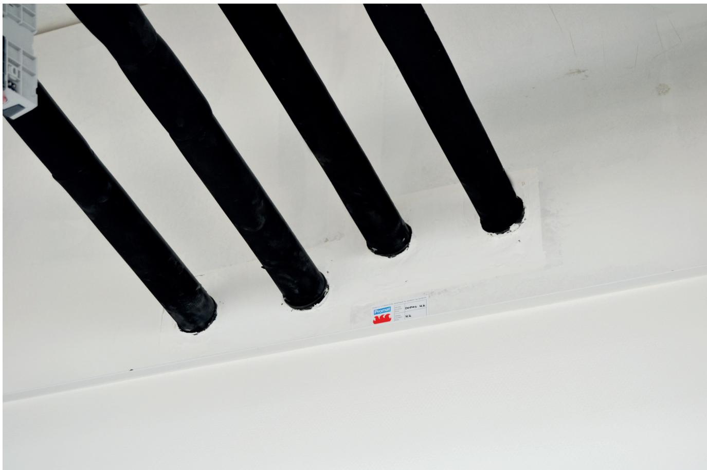
Prostupy potrubí s požárně ochranným pásem PROMASTOP®-W
