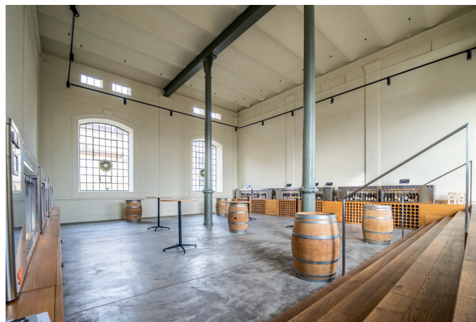
Protipožární nátěr PROMAPAIN® SC4 litinových sloupů (posudek) a nátěr ocelové stropní konstrukce
