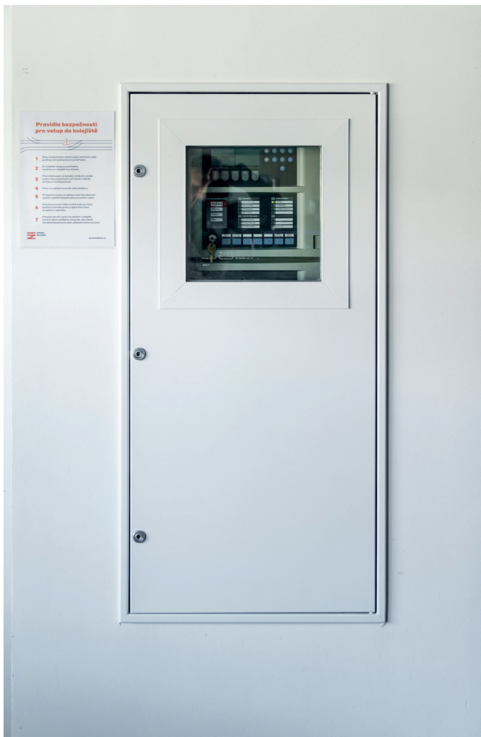
Revizní dvířka Promat®, typ SP s pevným prosklením PROMAGLAS®
