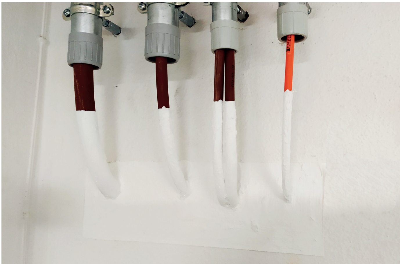
Kabelová měkká desková přepážka se stěrkou PROMASTOP®-I
