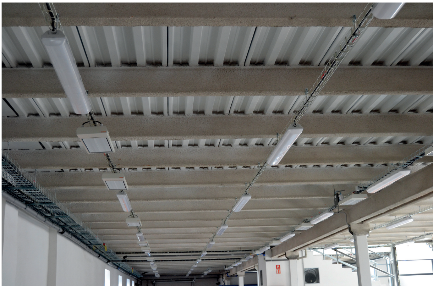
Ochrana ocelových nosníků nástřikem PROMASPRAY®
