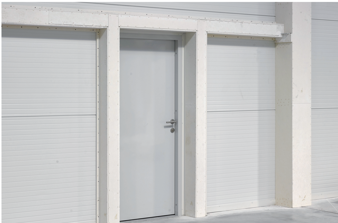
Obklad ocelové konstrukce deskami PROMATECT®-XS
