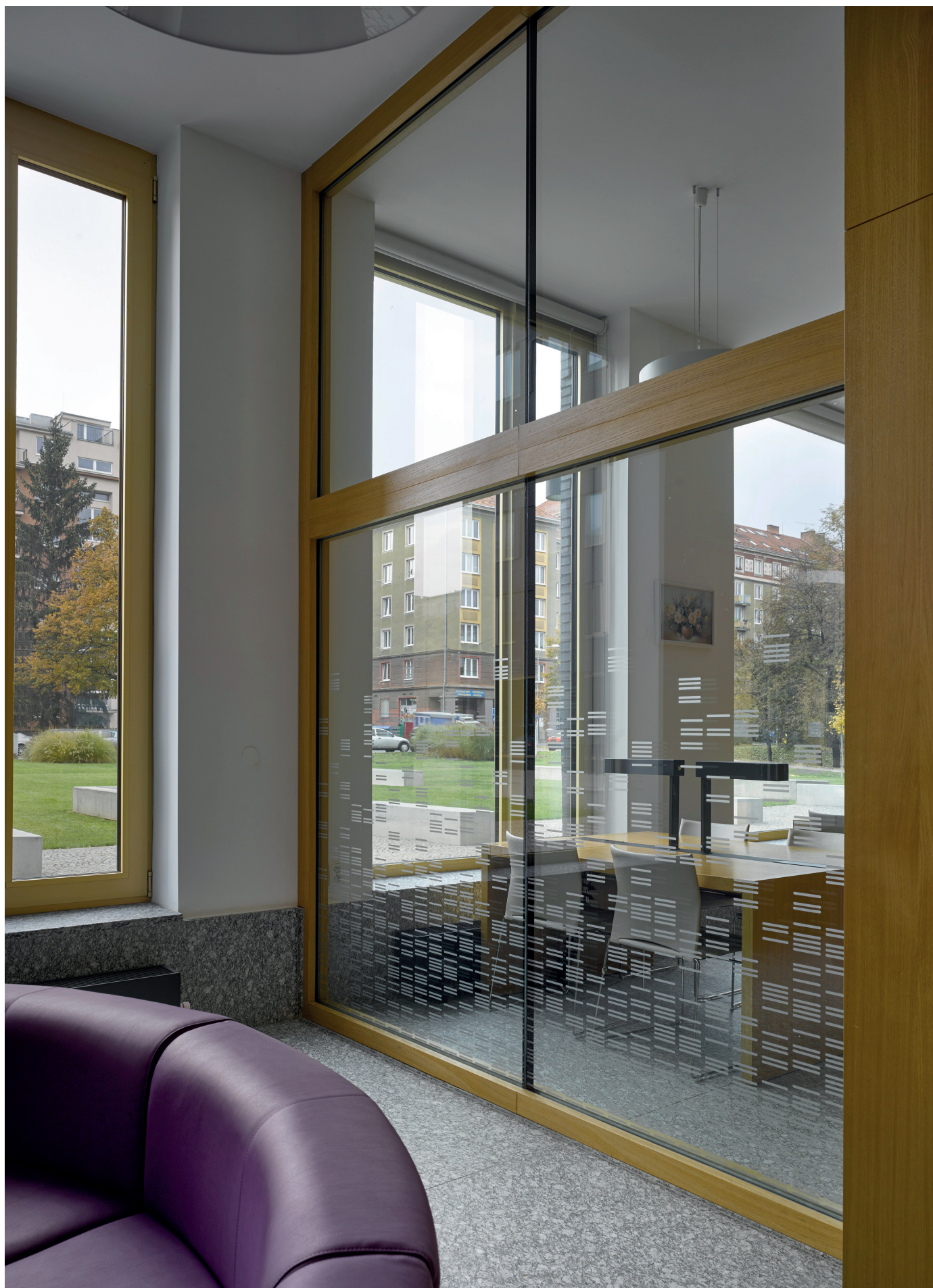
Celoprosklená systémová stěna PROMAGLAS® F1 se svislou silikonovou spárou
