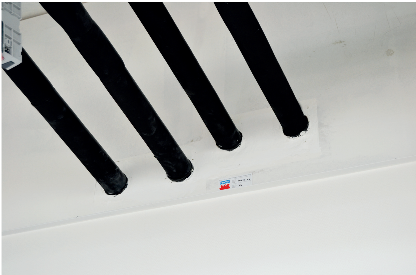
Prostupy potrubí s požárně ochranným pásem PROMASTOP®-W
