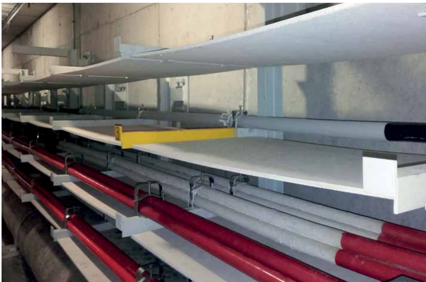
Podklady pod kabely v kolektoru - PROMATECT®-H
