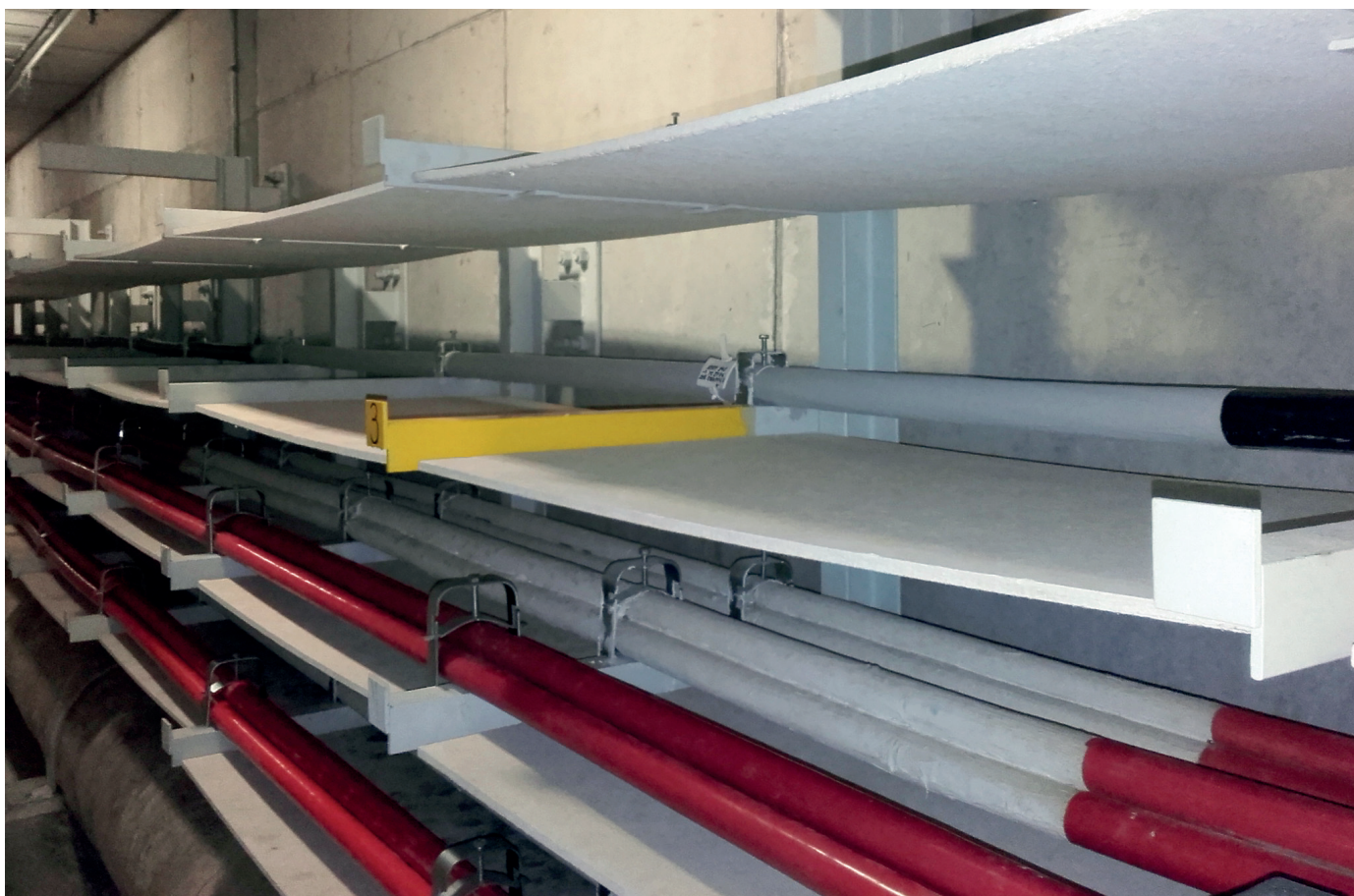
Podklady pod kabely v kolektoru - PROMATECT®-H
