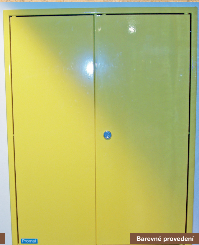
Ochrana původního rozvaděče
