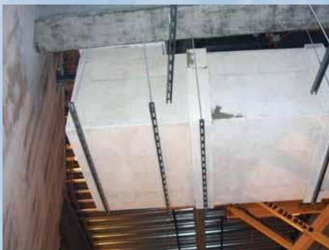
Příklad svislého potrubí PROMATECT®-L 500, EI multi 30
