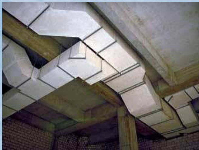
Příklad vodorovného potrubí PROMATECT®-L 500, EI multi 60
