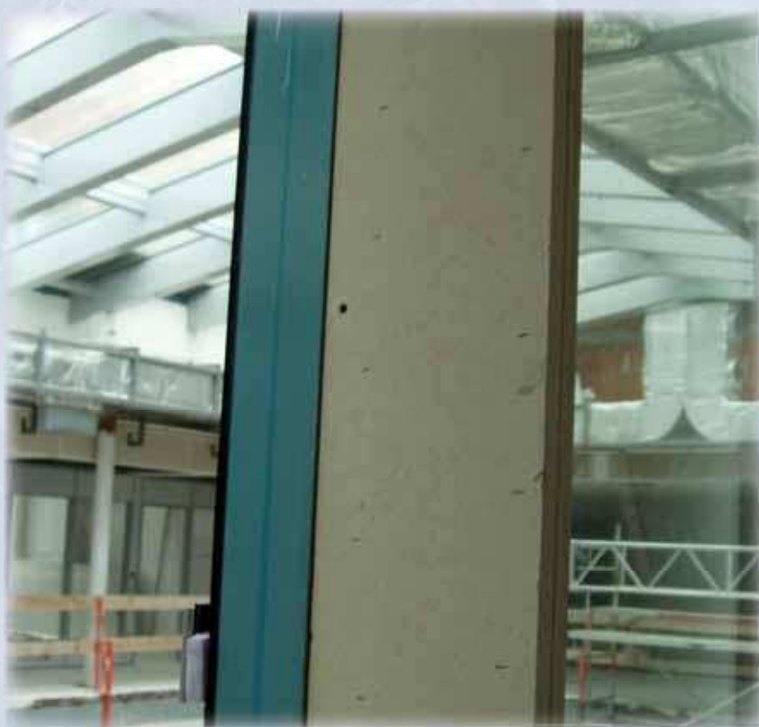
Obr. 6 – Administrativní budova v Ostravě-Porubě (bývalý OD TERČ) – příčka PROMATECT®-H pro dotěsnění budoucí požárně dělicí konstrukce
